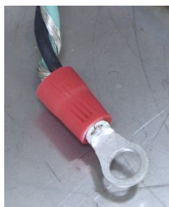
Figura 2-53: Terminación del cable de conexión a tierra
