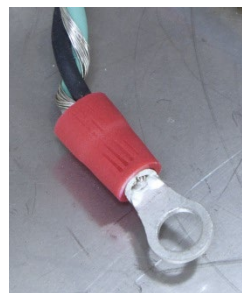
Figura 2-53: terminazione del cavo di messa a terra
