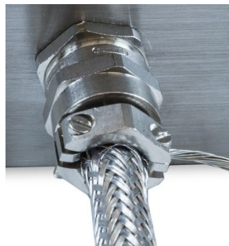
Figure 2-47 : Câble et presse-étoupe installés dans l'enceinte
