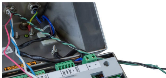
Figura 2-52: Fios de aterramento e fio de dreno interno torcidos juntos
