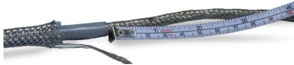
Figura 2-36: Marcación de la protección trenzada interna
